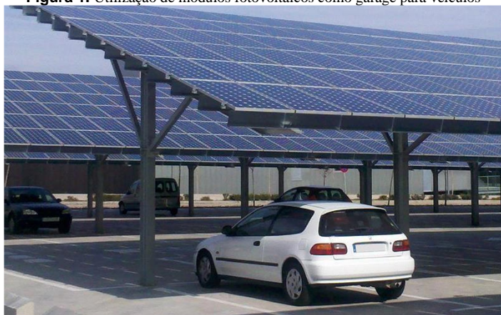
Figura 1. Utilização de módulos fotovoltaicos como garage para veículos
