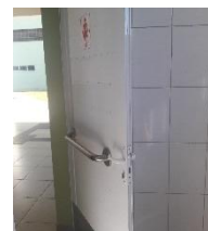
Figura 5: Porta de entrada banheiro acessível
