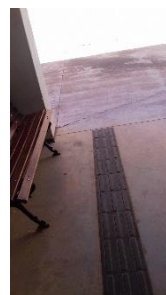
Figura 6 e 7: Sinalização tátil no piso.
