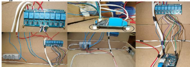
Figura 6. Instalação elétrica dos componentes utilizados na automação.
